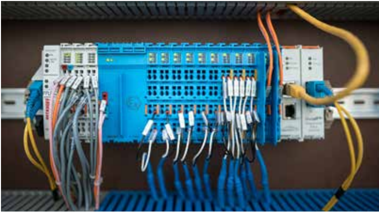
Mit dem eigensicheren ELX-System können die Signale direkt aus dem Ex-Bereich erfasst und verarbeitet werden.
