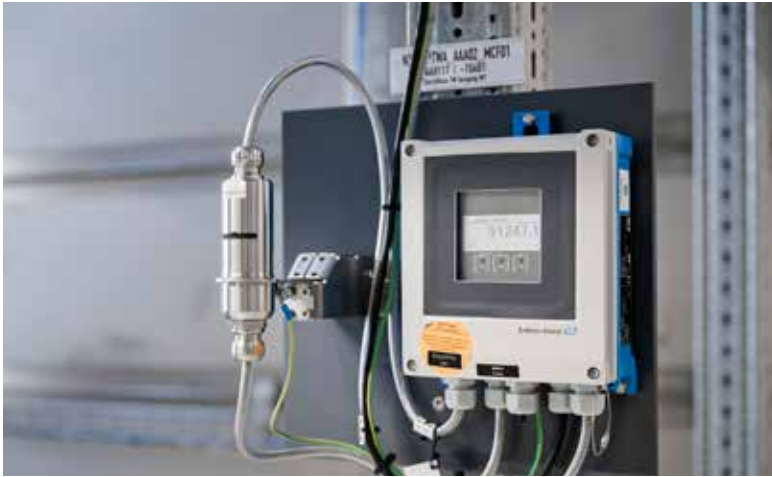
Der WirelessHART-Adapter FieldPort SWA50 (links im Bild) kann in Bestandsanlagen nachgerüstet werden und bringt Messgeräte in die Cloud.
