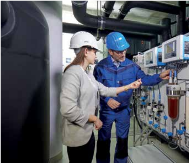
Memosens-Sensoren können parameterübergreifend per Plug-and-play eingesetzt werden.
