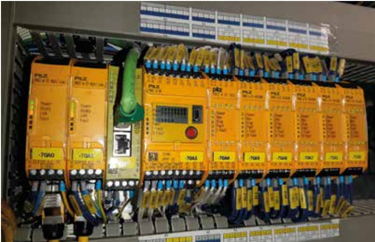
Die Kleinsteuerung PNOZmulti 2 steuert alle Sicherheitsfunktionen, wobei auf dem beleuchteten Display bei Bedarf auch Statusanzeigen abgerufen werden können.
