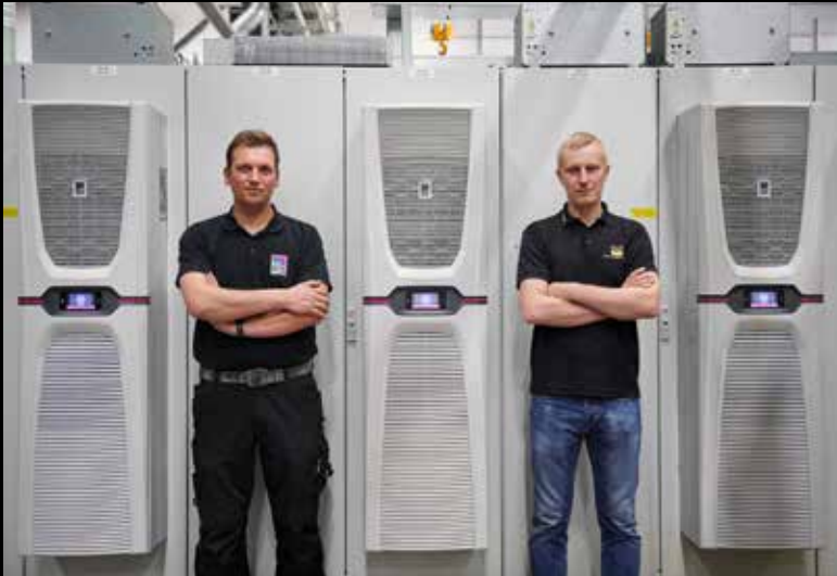
Nur 22 Tage hat die Umrüstung der 138 Kühlgeräte gedauert, eine Teamleistung von Rittal und Viega: Jan Reifschläger (links), Rittal Service, und Thomas Schild, Viega
