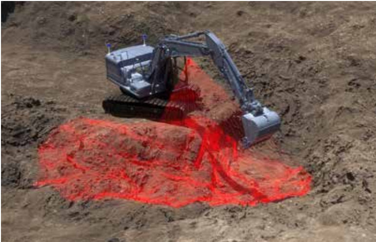
Mittels Laser- und Kameratechnik wird der Aushub ermittelt und mit Bildern und 38 Millionen georeferenzierten Messpunkten erfasst.
