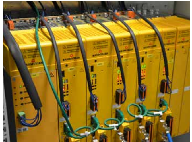
Die kompakten Umrichter des Anreihsystems b Maxx 5300 reduzieren den Verdrahtungsaufwand.
