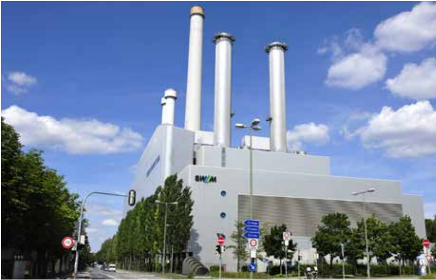
Das Heizkraftwerk Süd in München setzt auf Kraft-Wärme-Kopplung (KWK). Erdgasbetriebene Turbinen produzieren Strom, aus der Abwärme entsteht Fernwärme.
