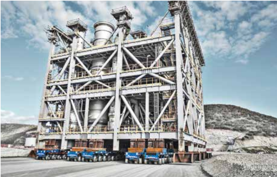
Die Kraftpakete der TII Group haben schon einige Weltrekorde aufgestellt – mit Transportgewichten bis zu 20.300 Tonnen.
