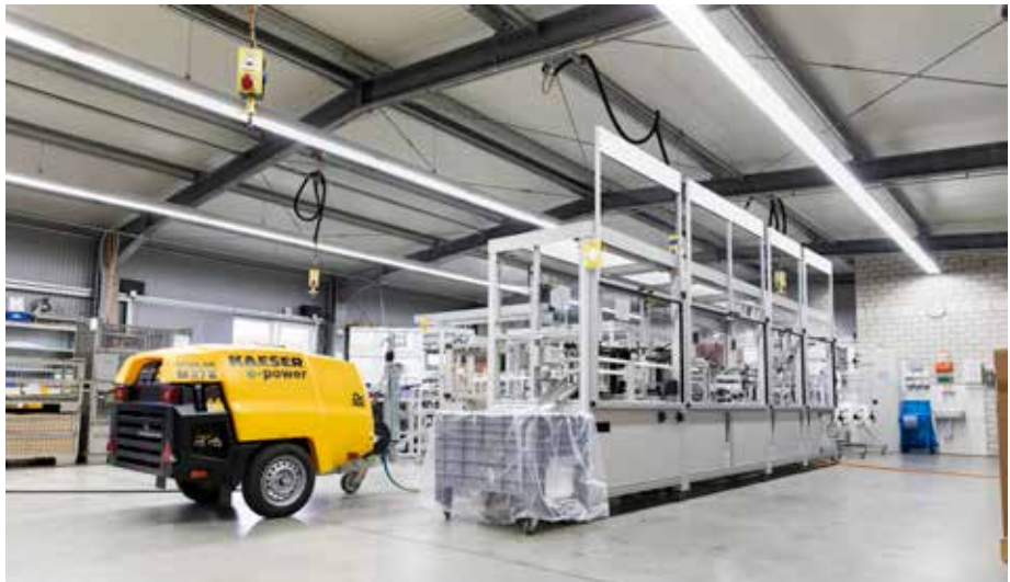
Mobile Baukompressoren mit Elektroantrieb können auch innerhalb von Gebäuden aufgestellt werden, wie es bei Unimatic der Fall war.
