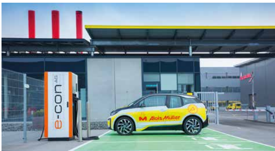
Mit dem selbst produzierten Strom wird eine eigene E-Tankstelle betrieben. Fahrer von Elektrofahrzeugen finden hier 10 Ladepunkte mit bis zu 150 kW, die ausschließlich mit klimaneutralem Strom versorgt werden.
