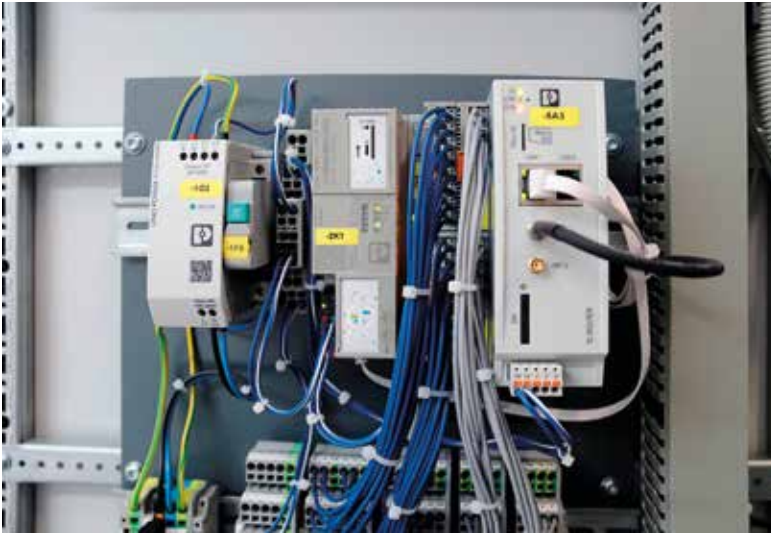
Neben der PLCnext-Steuerung AXC F 2152 (Mitte) nutzt die Stadt Laatzten die eine Stromversorgung der Produktfamilie Uno (links) sowie ein TC Modem (rechts).
