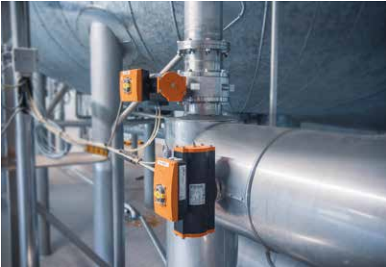
Basis für die neu entwickelte H0-Klappe war die seit Jahrzehnten bewährte T200-Armatur, eine mit PTFE ausgekleidete Absperrklappe.
