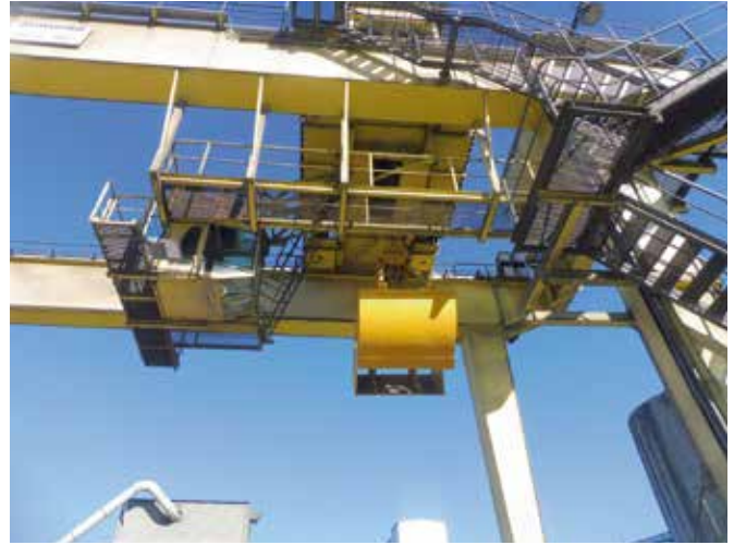
Der erfolgreiche Tausch der Hubwerksgetriebe am Greifer-Portalkran stellt die künftige Entladung der anlandenden Schiffe sicher.
