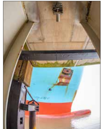
Das gibt es nur in Bremerhaven: Radarsensoren Vegapuls 6X überwachen das Anlegen der Schiffe und schützen die Kaje vor Schäden.
