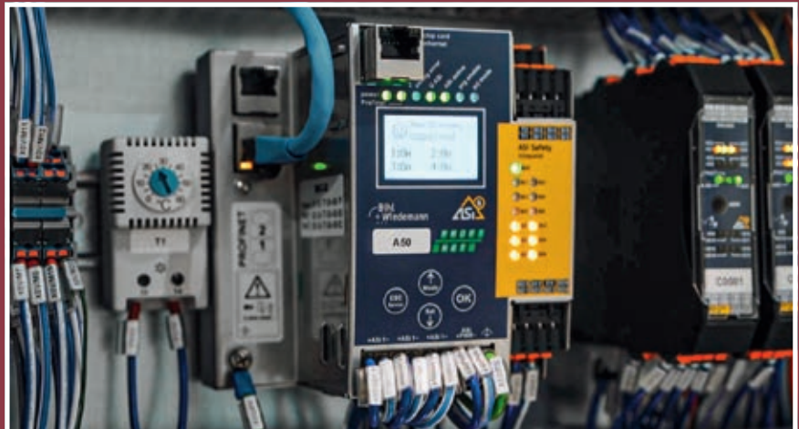
ASI-5/ASI-3 PROFINET Gateway BWU3862 mit integriertem Sicherheitsmonitor (links) und selbstkonfigurierende E/A Module ASI-5 BWU3884 in IP20 (rechts) von Bihl+Wiedemann.
