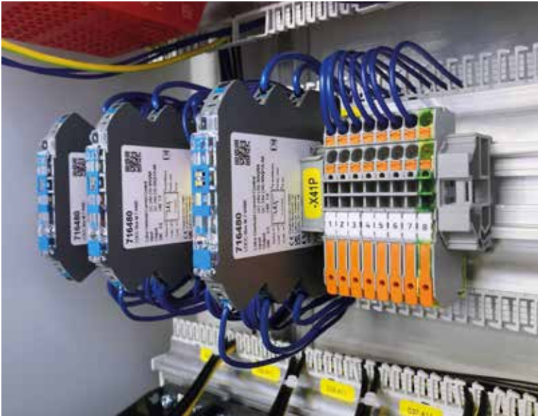
Platz sparen und auf der sicheren Seite mit der neuen Lütze LOCC-Box-M im Miniaturformat und dem kanallosen AirStream Verdrahtungssystem.
