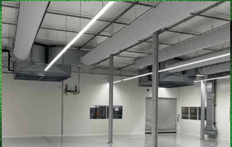
Prüfkammer für Batterietests.
