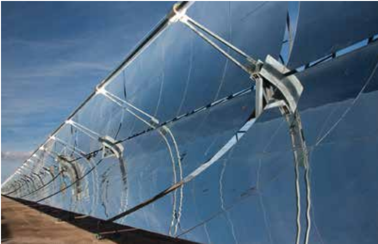
Parabolspiegel sind in der Lage, die Sonnenstrahlen auf einen Punkt zu konzentrieren.
