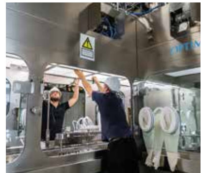
Abfüll- & Verschleißanlage für Covid-19-Impfstoffe.
