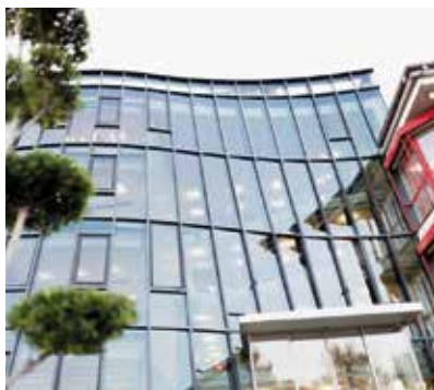
Firmenhauptsitz in Hattersheim am Main
