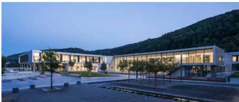
Bürkert Campus Criesbach: Das neue Produktions-, Logistik- und Bildungszentrum.
