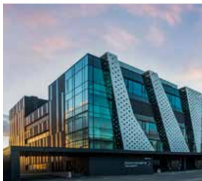
Das neue binder Produktions- und Logistikzentrum.
