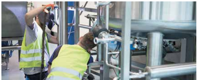
Anlagenmontage und Verkabelung bei einem Pharmakunden.
