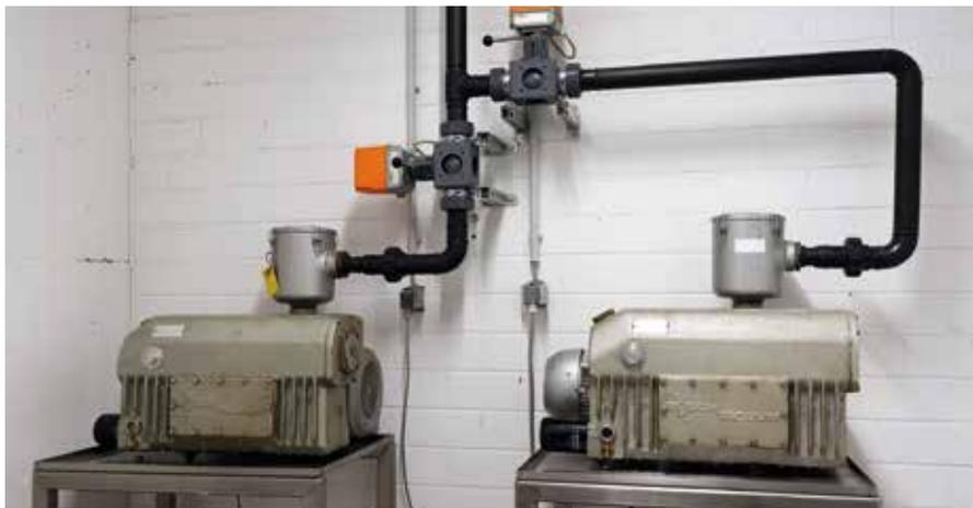
Zwei R5 Drehschieber-Vakuumpumpen von Busch sorgen für das korrekte Vakuumniveau zur Entgasung der Porzellanmasse vor der weiteren Bearbeitung.
