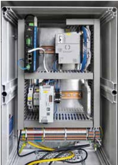
Die Schaltschranklösung Smart City Box-Environmental Control dient zur Aufnahme von Umweltmessdaten über das integrierte LoRaWAN-Gateway.
