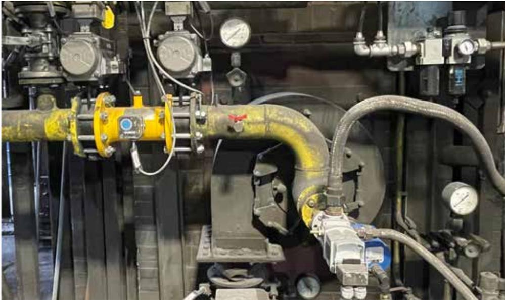
Um heutigen Sicherheitsanforderungen an den gasbefeuerten Kokstrocknungsofen zu erfüllen, mussten ein doppeltes statt früher einfaches Absperrorgan mit Dichtheitskontrolle, eine Gasdruckkontrolle für die Zündelektronik, eine Flammüberwachung und das Brennerluftgebläse in die Sicherheitskette eingebunden werden.
