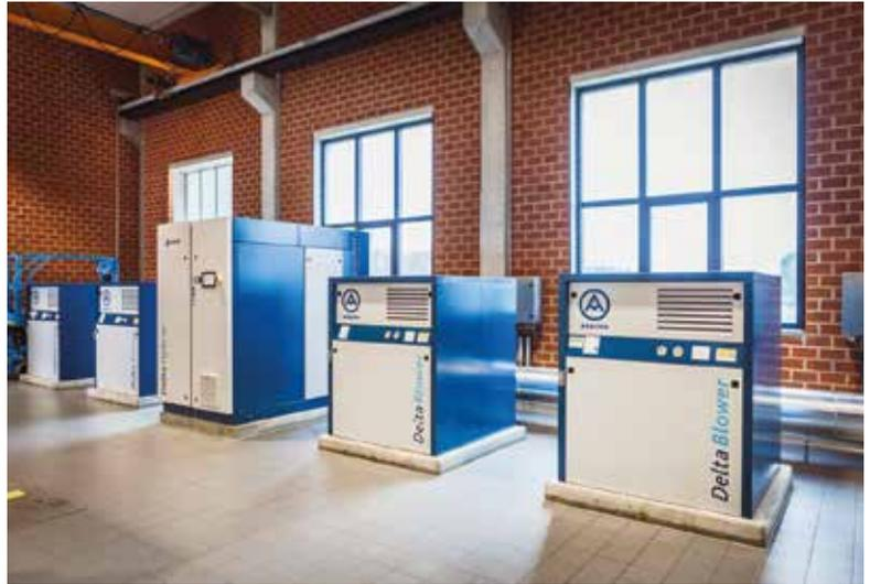
Side-by-side-Aufstellung und der hervorragende Volumenstrompro-Quadratmeter-Wert führen zu klein dimensionierten Maschinenräumen und damit zu geringeren Gebäudeinvestitionen. Kapazitätserhöhungen auf engstem Raum sind so realisierbar.
