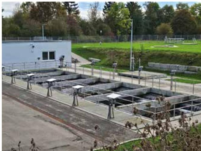
**Der AZV Oberer Neckar hat als weitere Reinigungsstufe einen GAK-Filter zur Entfernung von Spurenstoffen auf dem Kläranlagengelände gebaut.**
