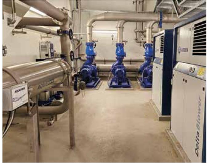
Damit der GAK-Filter seine Funktionsfähigkeit behält, muss er regelmäßig mit Luft und Wasser gespült werden.
