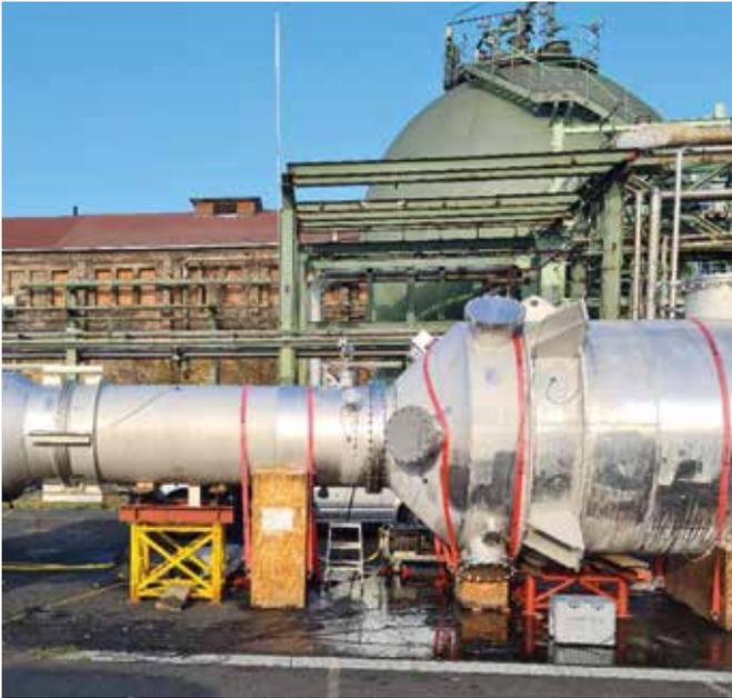
Materialermüdung und daraus resultierende Rissbildungen an Anlagenkomponenten bergen Risiken. Mit dem Acoustic Emission Testing lassen sich solche Fehlstellen frühzeitig erkennen.
