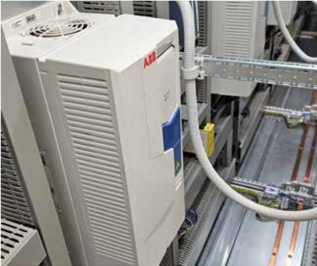
Sieben ABB-Frequenzumrichter ACQ580 regeln in der Anlage die Spülaggregate.
