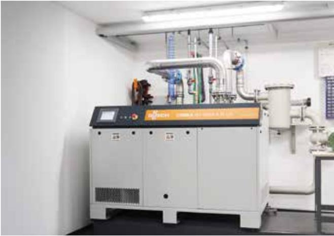
Die Cobra-NX-Schrauben-Vakuumpumpe sorgt für zuverlässige und effiziente Versuchsbedingungen.
