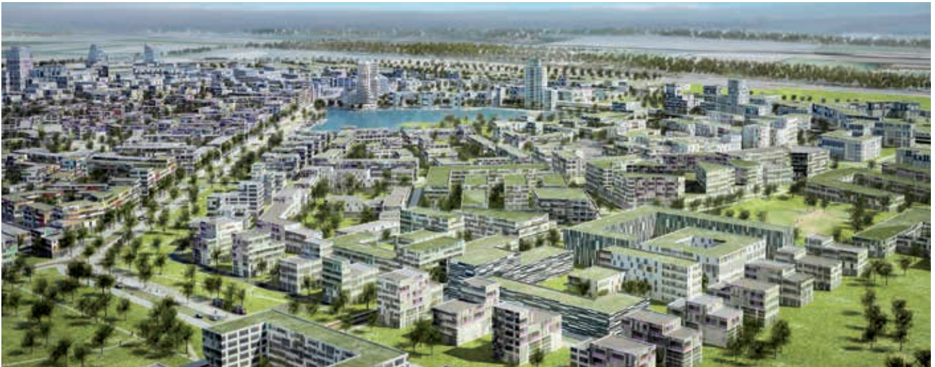
Großbaustelle: Vor den Toren Wiens entsteht ein Quartier für 20.000 Menschen.
