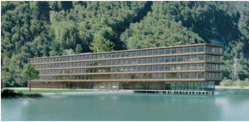
Holz-Hybrid: Das im LCT-System errichtete Wasserkraft-Kompetenzzentrum der Illwerke in Vandans im Montafon hat fünf Stockwerke und über 10.000 qm Bruttogeschossfläche.
